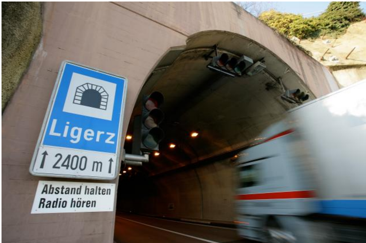
Der Twanntunnel ist kein eigener Tunnel, sondern die Verlängerung des Ligerztunnels um 1,8 Kilometer bis Twann. copyright: patrick weyeneth/a
