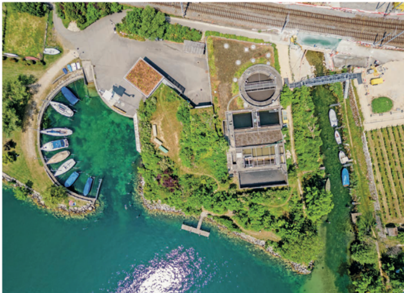
Die ARA am Twannbach beim Bootshafen Twann ist sanierungsbedürftig.
